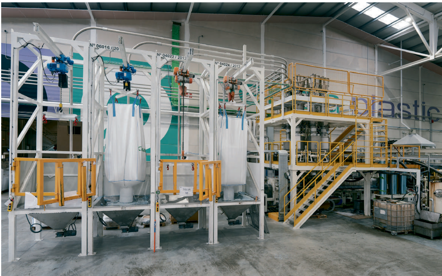
Planta de la empresa Benzaplastic, en el polígono Llano Mazuelos, en Alcalá la Real.
