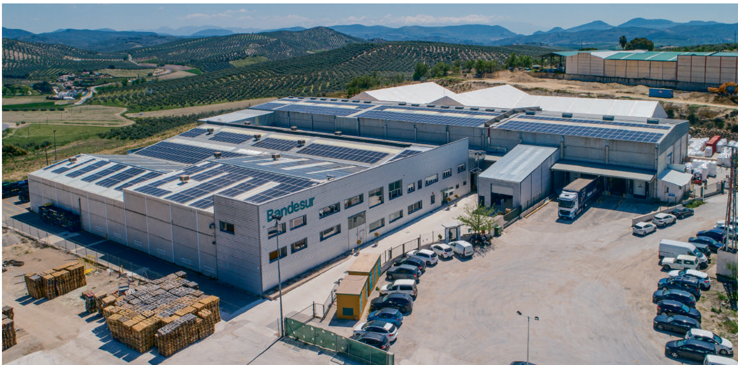
Planta de Grupo Bandesur, en el polígono industrial El Chaparral, en Santa Ana, Alcalá la Real.
